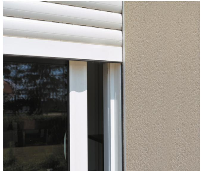
Sur la gamme Alizéa, les coulisses de volet roulant en pose applique (pose en neuf) sont intégrées dans l'épaisseur de doublage et sont alors masquées pour une discrétion totale.
